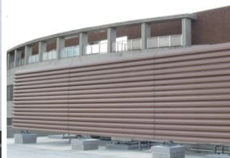
意匠性の高い トーンスクリーン Soundproof louver with superior design
