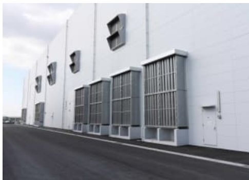
風を通して騒音防止 工場給気口ダクトサイレンサー Duct silencer for factory ventilation
